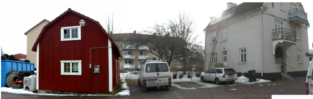
Befintlig bebyggelse inom Norrbyåkern 7.
