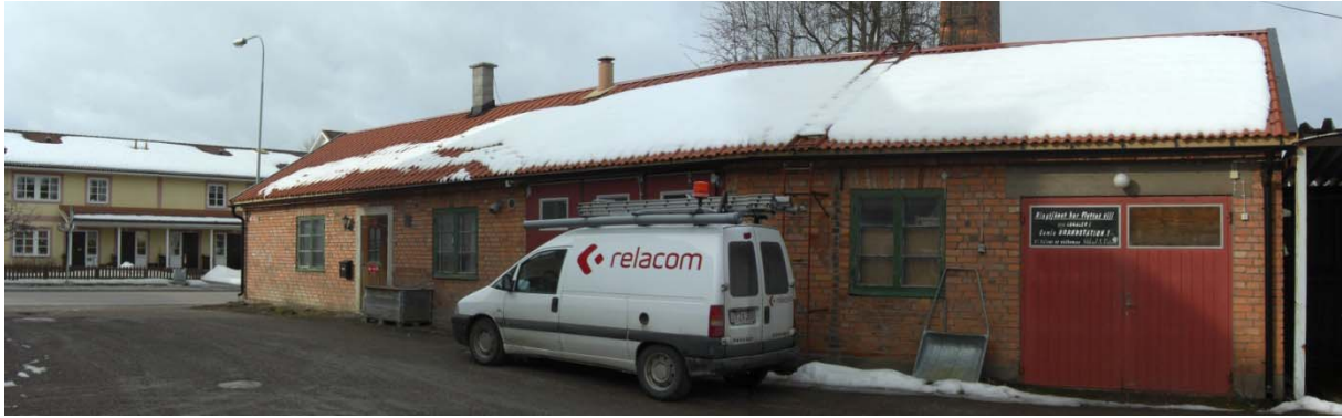
Befintlig bebyggelse inom Norrbyåkern 6
