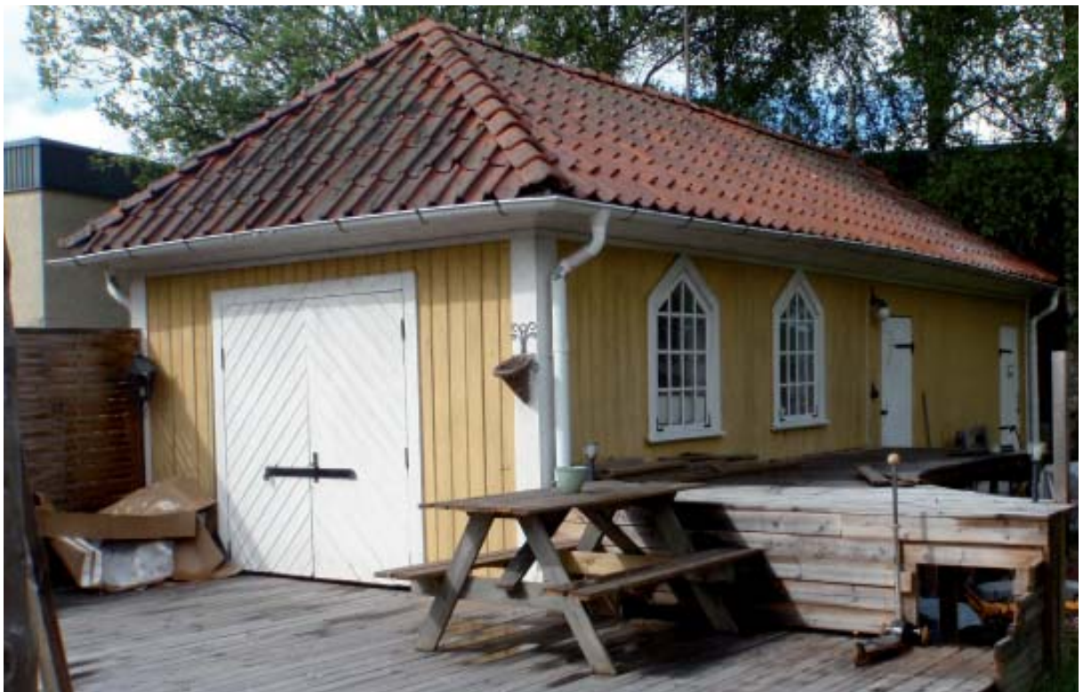
Tillhörande bod har anpassats till huvudbyggnadens i färger, material och takform.
