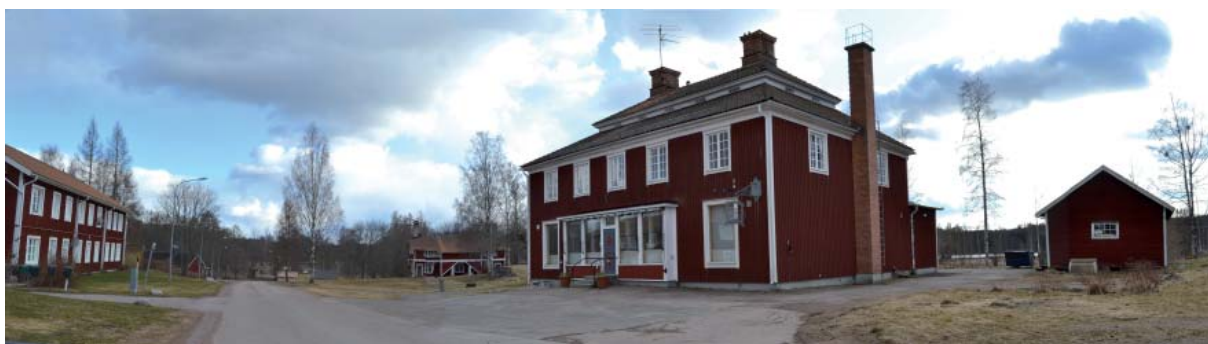
Tryckeriet uppfördes ursprungligen som affär 1921.
